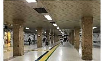
④南北線と東西線をつなぐコンコース
