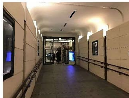
③ビル間地下通路
