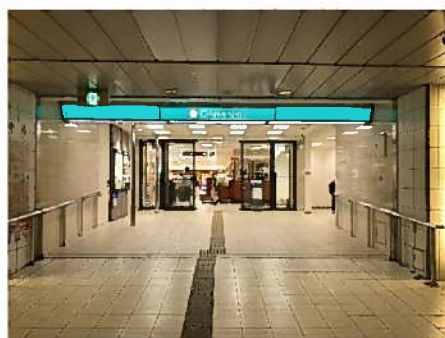
⑤ビルとの地下接続部
