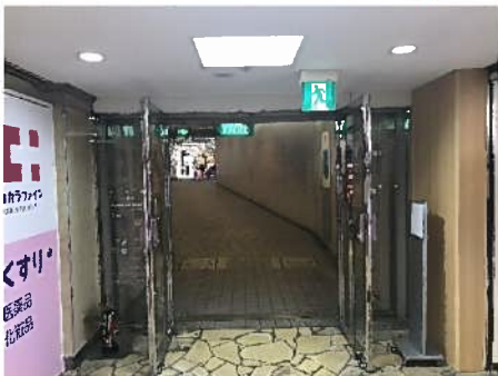
③ビル間地下通路
