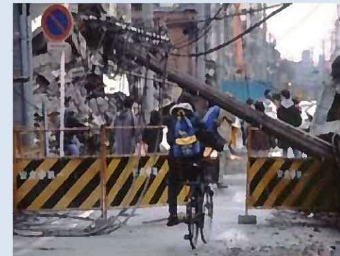
【地震により倒壊した電柱(兵庫県)】
