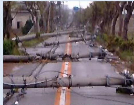
【台風の影響で道をふさぐ電柱(沖縄県)】
