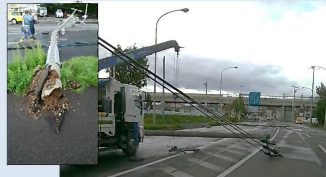
【台風の影響で電柱が倒壊(札幌市、国道275号)】
