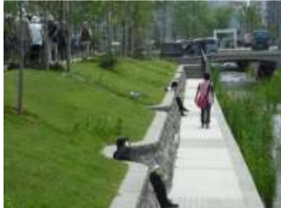
二段護岸による整備
