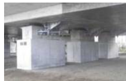
橋梁の耐震化（橋脚補強等）
