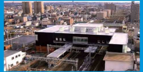
JR白石駅周辺地区整備▲
