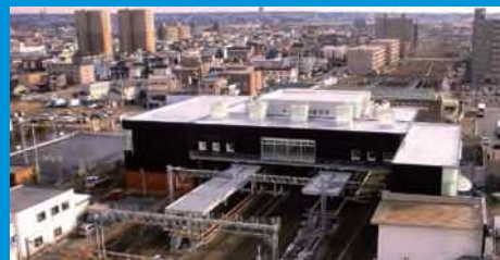
JR白石駅周辺地区整備▲
