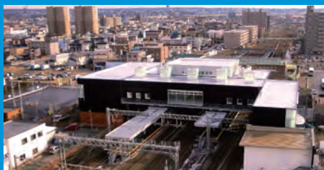
JR白石駅周辺地区整備 ▲
