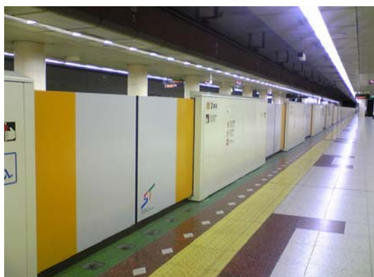
地下鉄東西線ホーム柵設置状況
