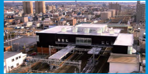
▲ JR白石駅周辺地区整備
