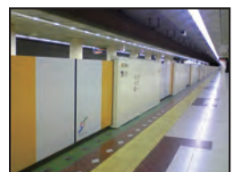
▲地下鉄全線ホーム柵設置
