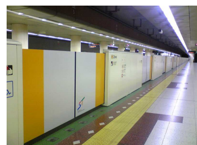
地下鉄ホーム柵
