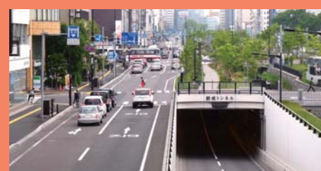
▲創成川通連続アンダーバス▲
