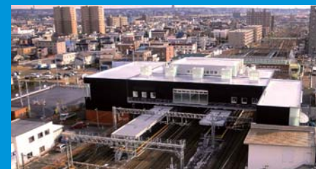
JR白石駅周辺地区整備▲
