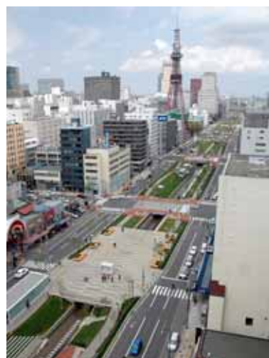
（左）創成川通（創成トンネル） （右）創成川公園（狸二条広場）
