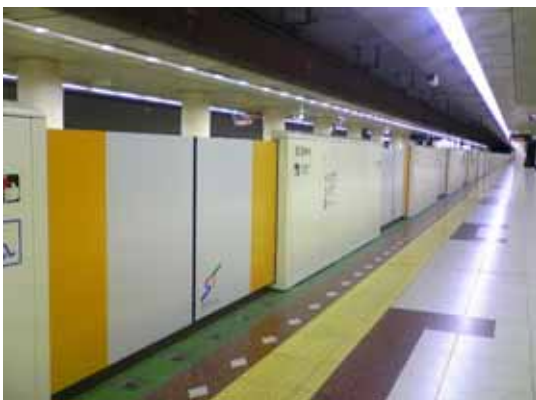
地下鉄東西線ホーム柵設置状況
