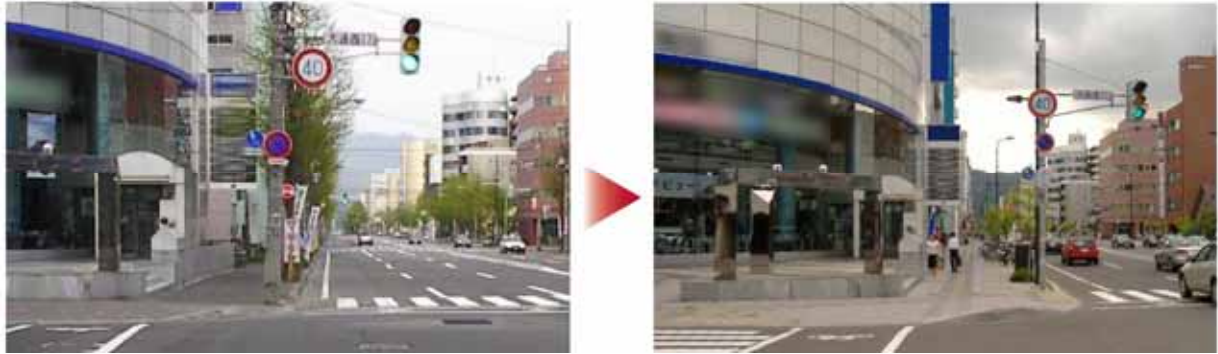
歩道バリアフリー化の推進（左：整備前、右：整備後）
