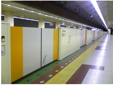
写真 3-1 地下鉄ホーム柵
