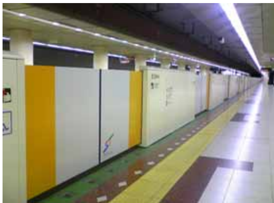
地下鉄東西線ホーム柵設置状況
