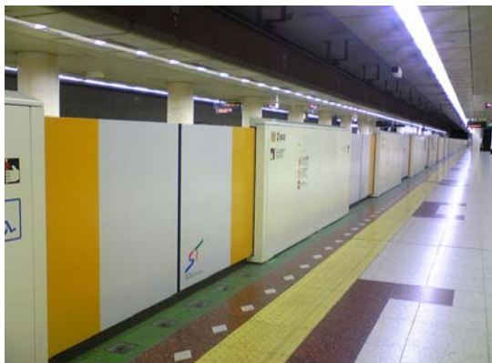
地下鉄東西線ホーム柵設置状況
