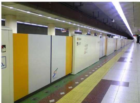
地下鉄東西線ホーム柵設置状況
