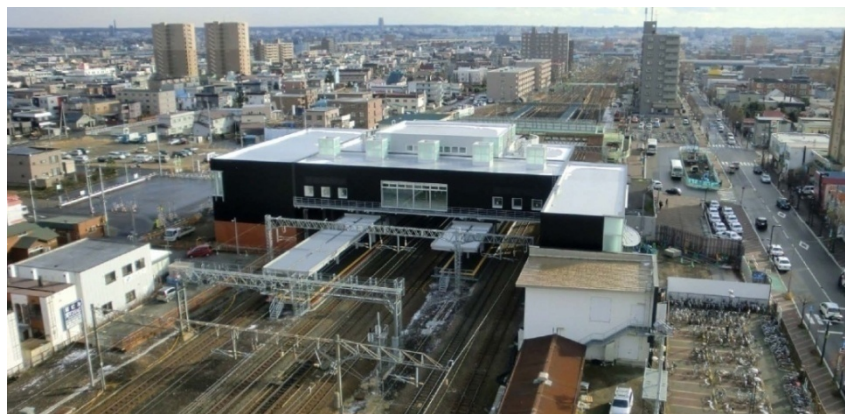
JR白石駅周辺地区整備（手前：自由通路、奥：橋上駅舎）
