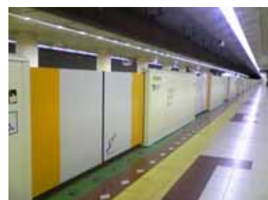
地下鉄ホーム柵
