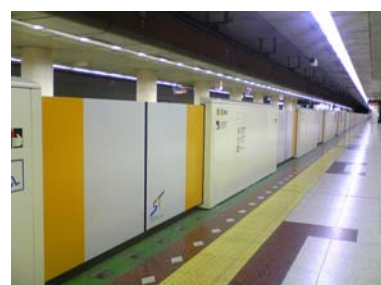
地下鉄ホーム柵
