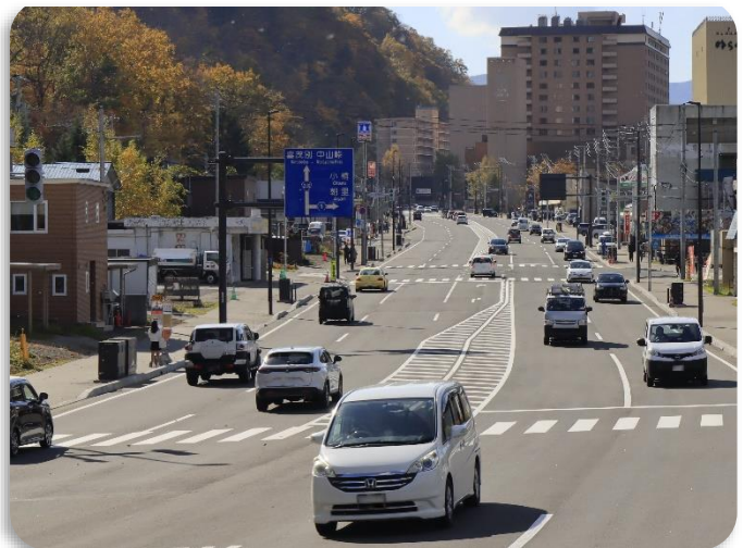
4車線で開通した 国道230号（石山～定山溪間）
