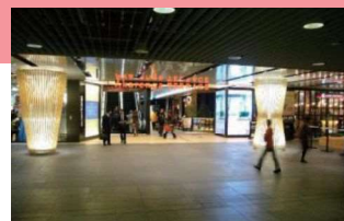
公民連携による地下歩行ネットワーク (地下歩行空間と民間ビルの接続)
