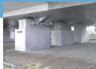
橋りょうの耐震化(橋脚補強等)
