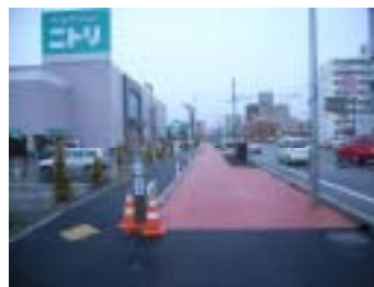
【整備後 - 国道12号】
