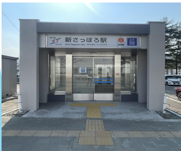
【エレベーター設置 (新さっぽろ駅)】
