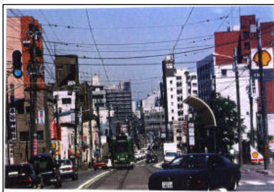
写真 架線の状況
