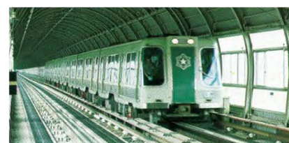
④雪を防ぐシェルター内を走る開業当時の南北線(南平岸-真駒内)
