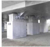
橋梁の耐震化（橋脚補強等）
