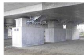
橋梁の耐震化（橋脚補強等）
