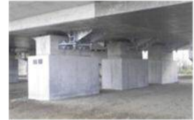
橋梁の耐震化（橋脚補強等）
