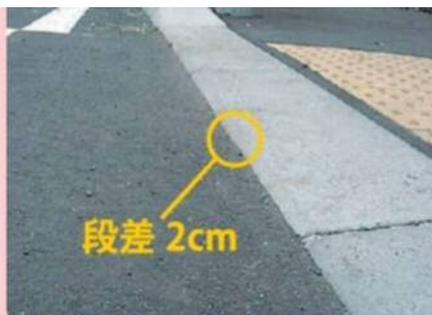
車いすを使用する方の通行が可能で、視覚に障がいのある方が車道と歩道の区別を認識できる段差です。
