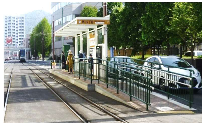
図 路面電車停留場のバリアフリー化（西15丁目停留場）
