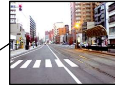
西7丁目通 拡幅状況
