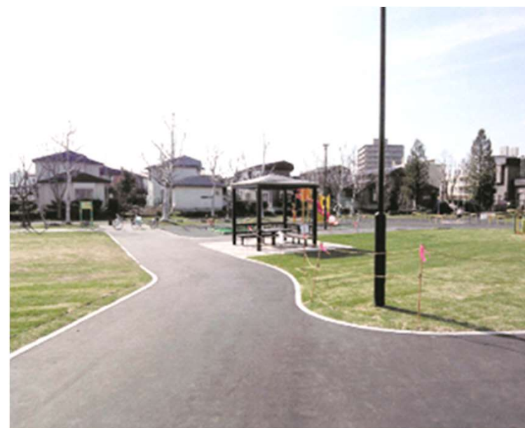
図 園路のバリアフリー化整備事例
