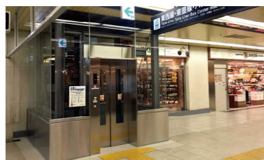
地下鉄コンコースへのエレベーターの設置
