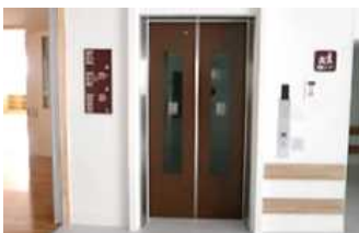
学校のエレベーターの設置
