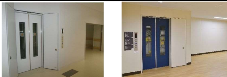
図 4-67 学校へのエレベーター設置状況
