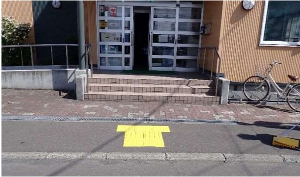
点字ブロックの設置例
