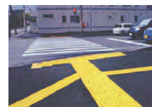
誘導用ブロック敷設
