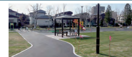
公園内休憩施設
