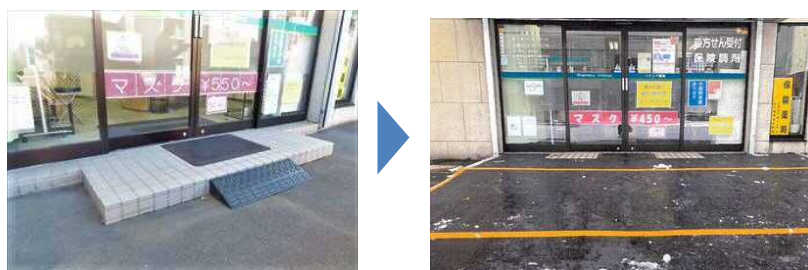
店舗入口の段差を解消した事例
