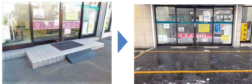
店舗入口の段差を解消した事例
