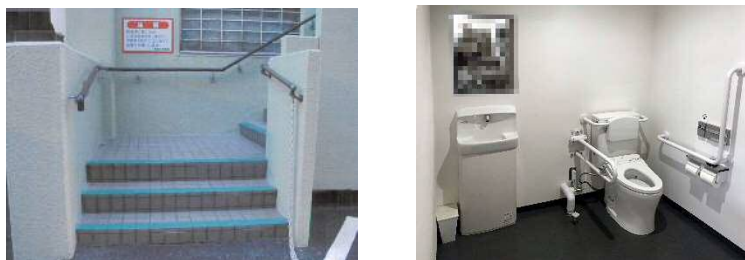
階段に手すりを設置した事例
