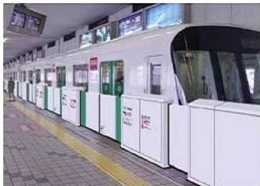
図 3-1 可動式ホーム柵の設置事例
