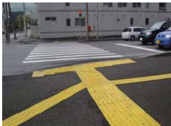
図 3-5 誘導用ブロック敷設の例
