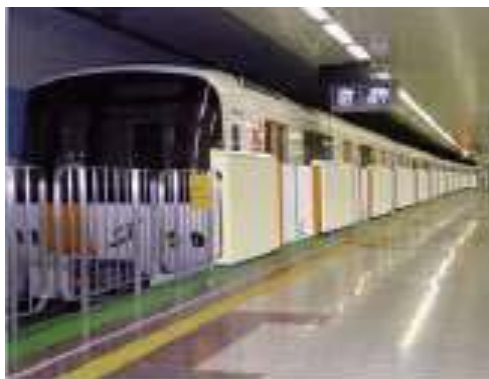
図 3-1 可動式ホーム柵の設置イメージ
