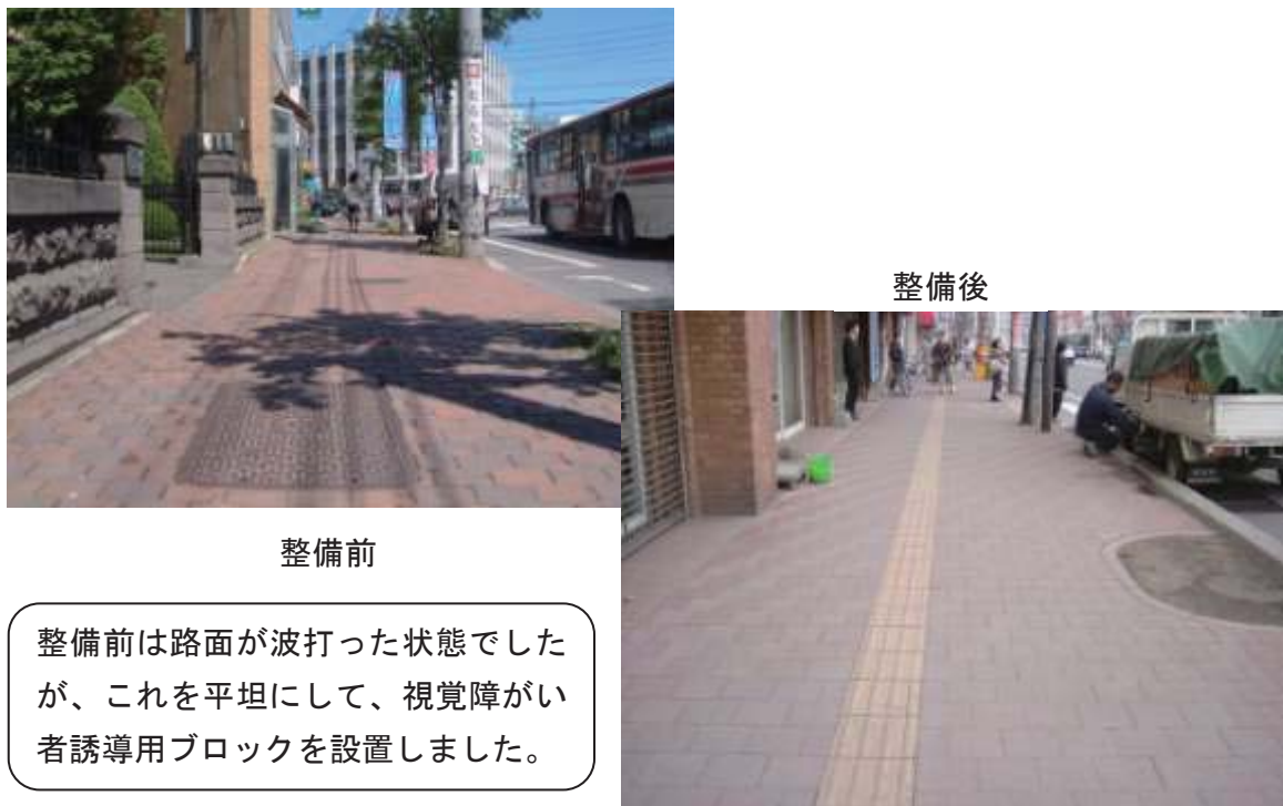
図 1-25 歩道のバリアフリー化（麻生地区 西 5 丁目樽川通）
