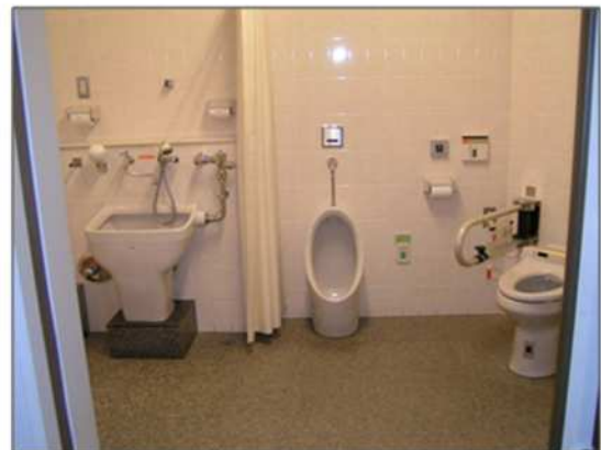
(多目的トイレ)
