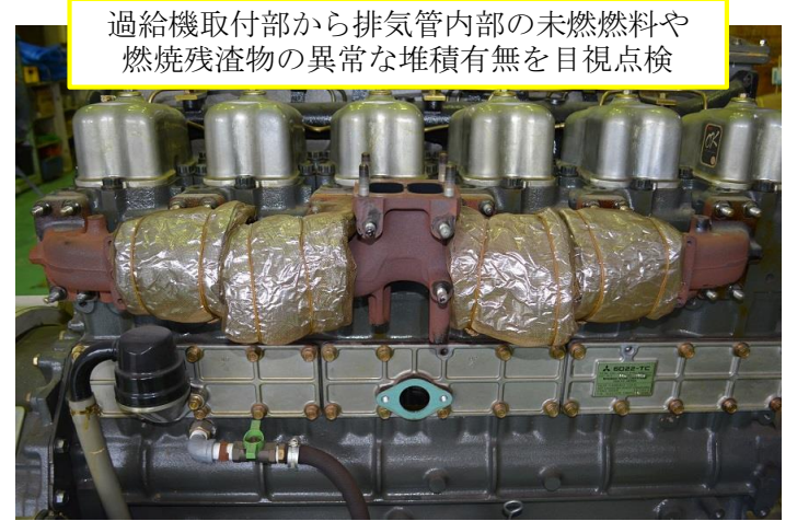
図2 排気管内部目視点検
