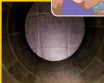
埋設されたままの状態で、タンク内面の全体に厚さが 2mm 以上になるように強化プラスチックを被覆するものです。
