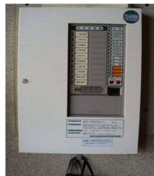
③自動火災報知設備
