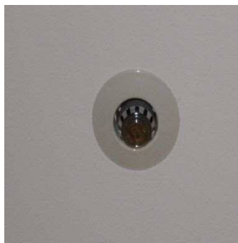
②スプリンクラー設備
