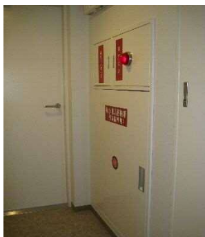
①屋内消火栓設備
