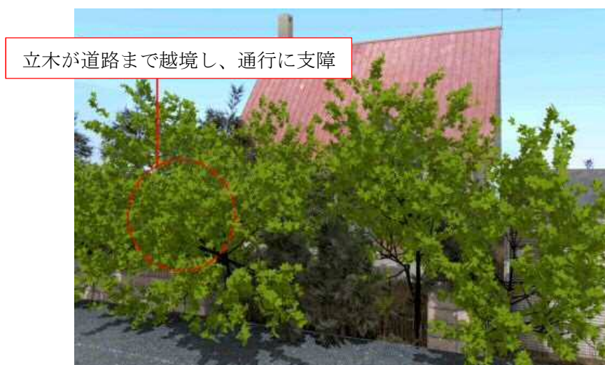
図5 道路通行・走行の支障
