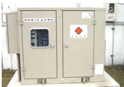
パッケージ型非常用発電機（例）
