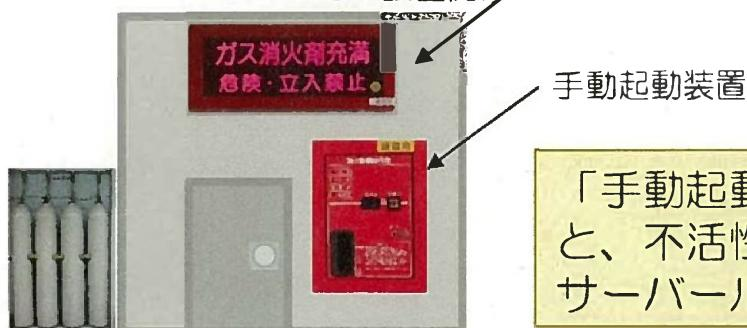
「手動起動装置」を操作し、起動すると、不活性ガス（二酸化炭素など）がサーバールーム内に放出される。
