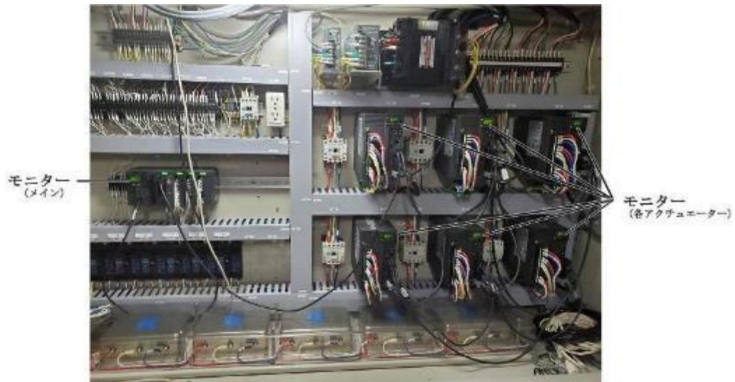
※制御盤の主電源を OFF にして強制終了すると、エラーや機械原点がリセットされるため、トラブルの原因が特定できない。また、起震台が外枠に乗り上げる危険性がある。
