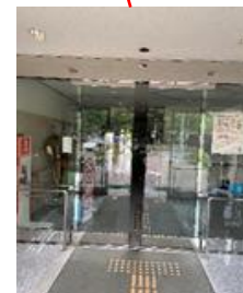
白石消防署正面玄関
