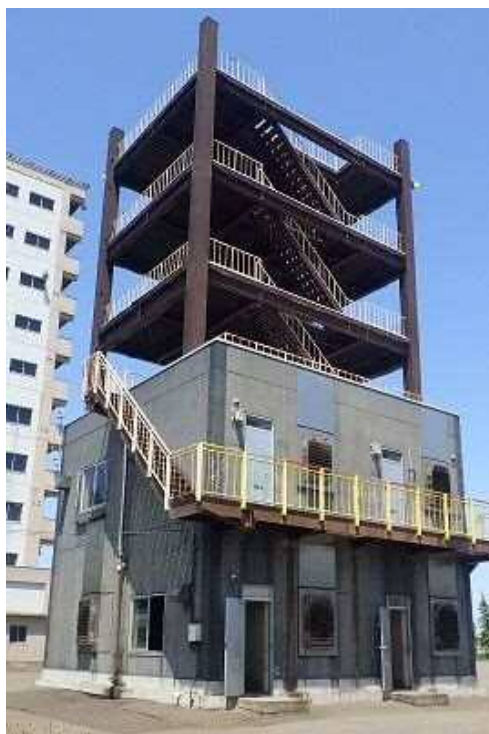
図3 消防補助訓練塔(外観：南面及び西面)
