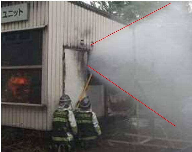
図4 建物に設定した水力換気ノズル(主ノズル)の放水状況
