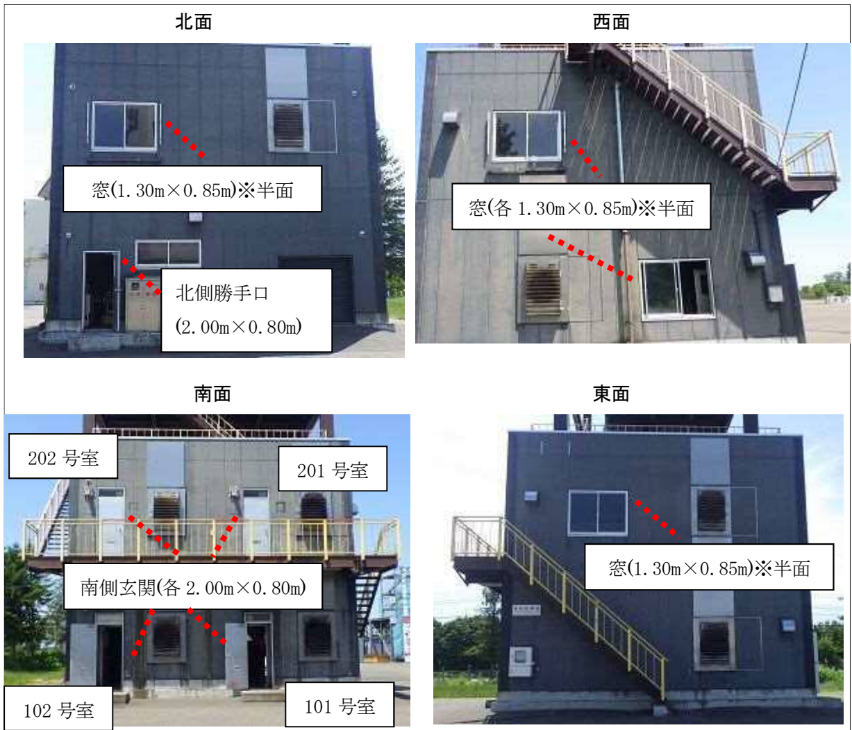
図5 消防補助訓練塔(各面)
