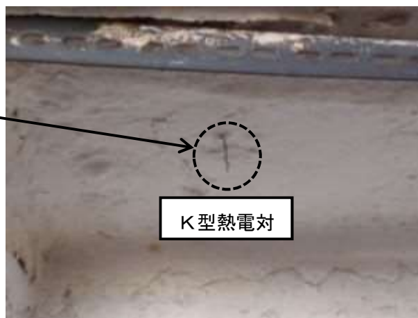
写真 1 2 K型熱電対設置状況 2
