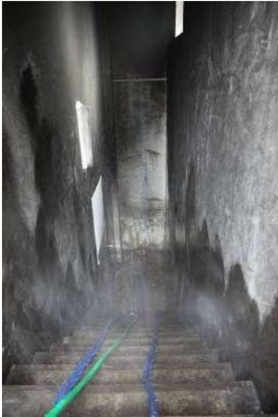
写真 6 散水チューブの設定及び水噴霧状況
