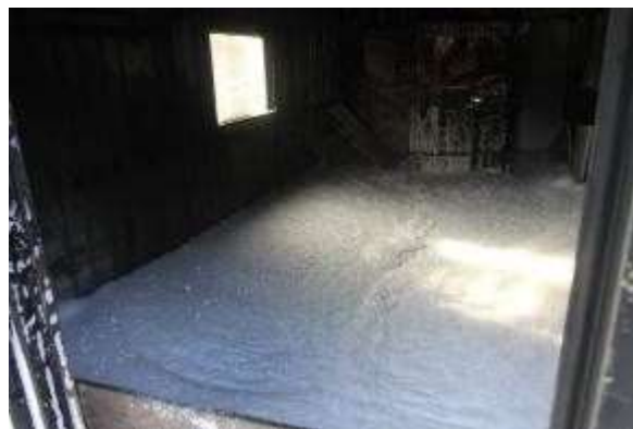
写真 2 室内の泡溜まりの状況
