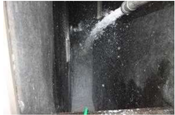
写真 7 泡の放射状況
